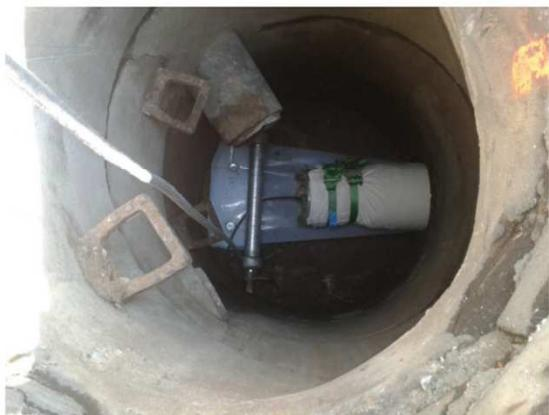
**Topf-Anbindung um Schlauchliner mit Druckluft aufzustellen**
