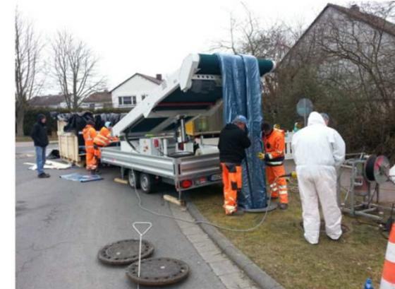
**Einbringen Schlauchliner Kanal (Förderband, z.B. bei großen Nennweiten)**
