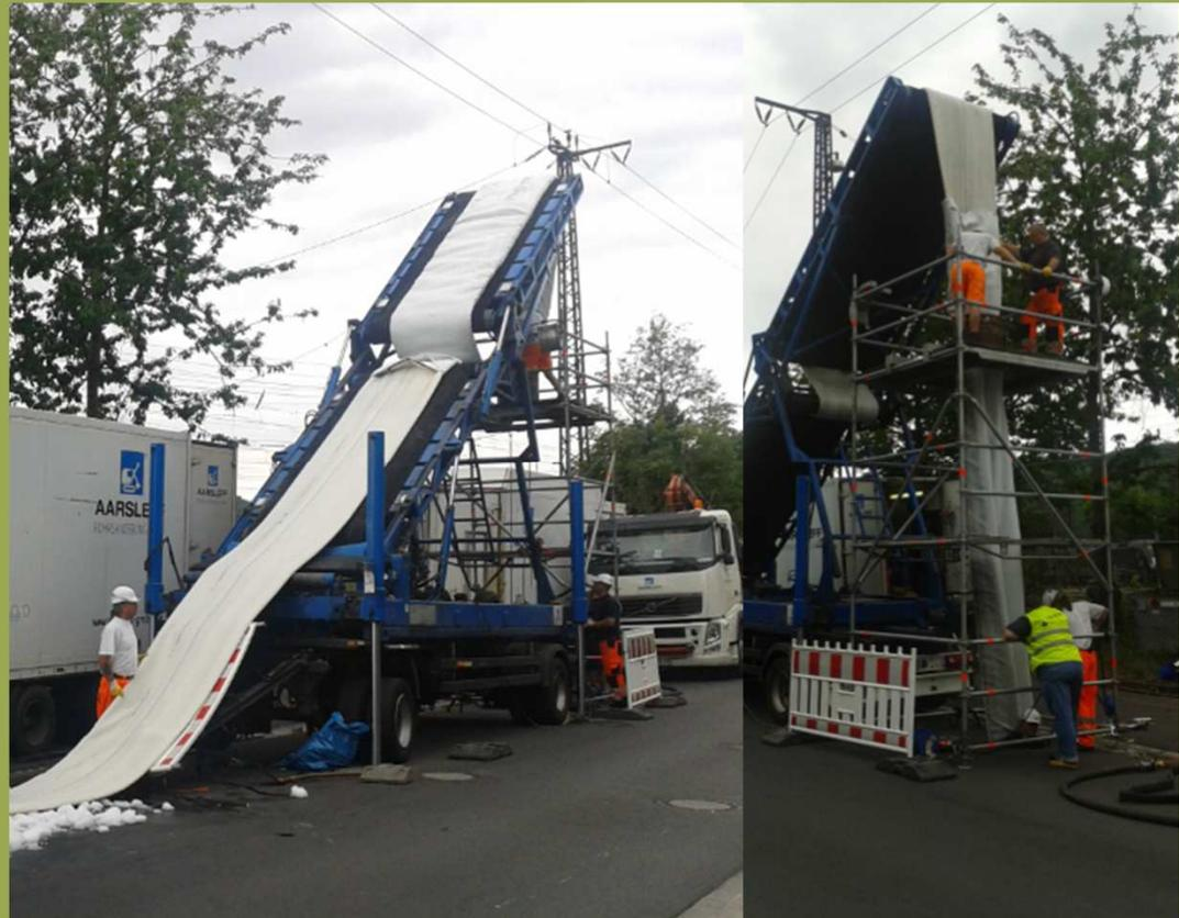
Einbringung (Inversion) mit Wasser und Aushärtung durch Wasserwärme
